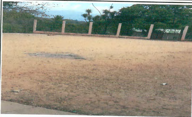
Foto 1: MEJORAMIENTO DE LOSA DE PATIO
