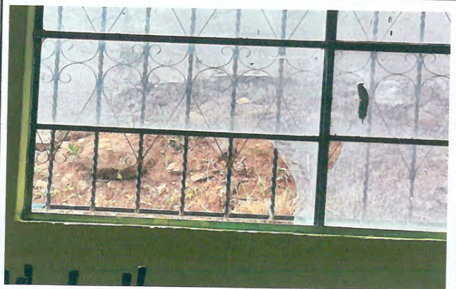
Foto 4: MEJORAMIENTO DE VENTANAS
