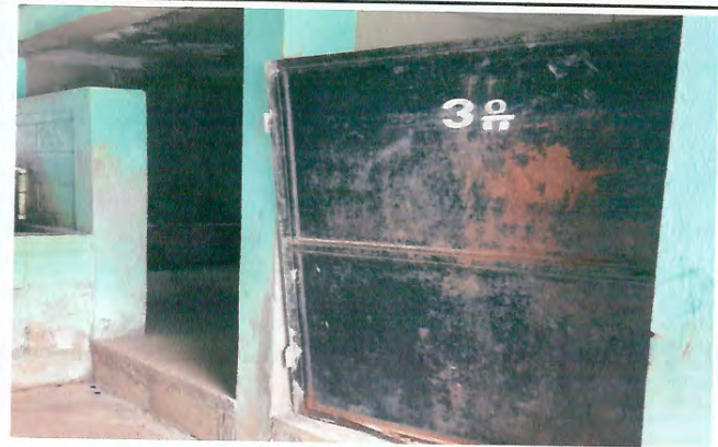
Foto 2: MEJORAMIENTO DE SERVICIOS SANITARIOS Y SUS ACCESORIOS
